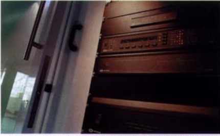
▲ Technik im Verborgenen: Hinter einer eleganten Glasschiebetür verbergen sich die Steuerung, der Musikserver, die Multiroomverstärker und verschiedene Zuspieldquellen. Mit dem drucksensitiven Monitor läßt sich unter anderem die Überwachungskamera im Schwimmbad steuern
